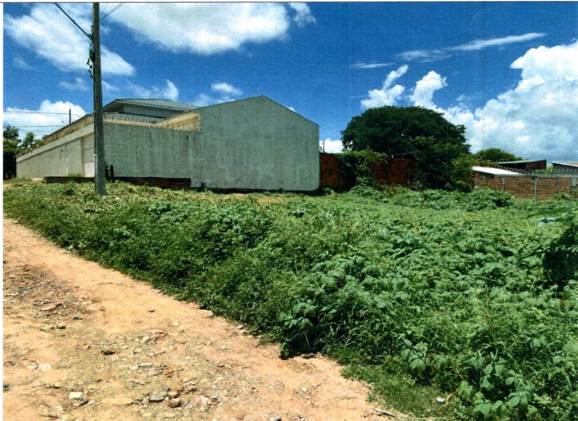
18- Vista apartir da divisa do lote
